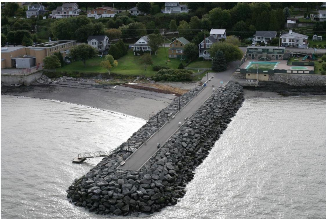
**Figure 1.** Vue aérienne du quai de Notre-Dame-du-Portage et du large enrochement le ceinturant (source : Photographies hélicoptés, 2010, LDGIZC).
