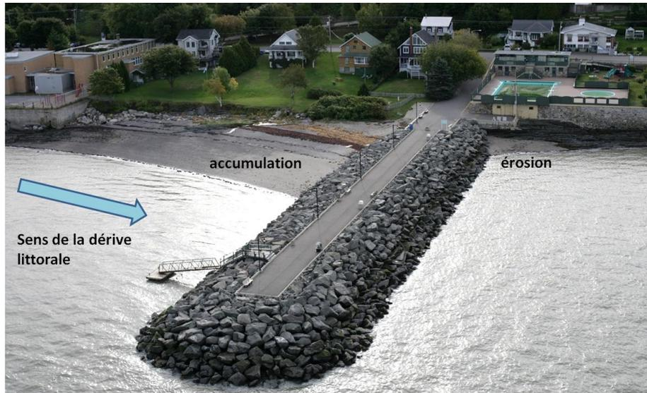
**Figure 3.** Illustration d'un transit sédimentaire amont/aval rompu par la présence d'une infrastructure perpendiculaire (Quai de Notre-Dame-du-Portage, source: Photographies hélicoptés, 2010, LDGIZC)
