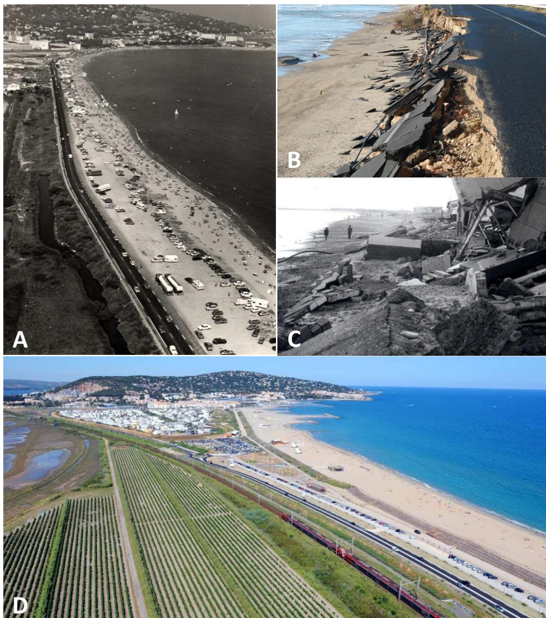
**Figure 4.** Route située près de la plage et stationnement anarchique avant les travaux de réhabilitation du Lido de Sète-Marseillan (A). Dommages causés par les tempêtes sur les infrastructures (B et C). Le lido suite aux travaux de recul de la route (D) (Thau Agglo, 2015).
