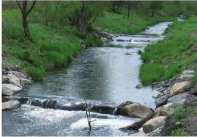
**Figure 8 :** Seuil dissipateur d'énergie pour contrôler la vitesse d'écoulement de l'eau
