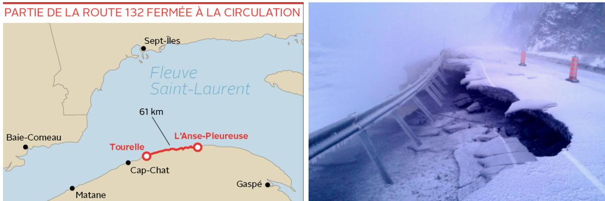
**Figure 2.** Tronçon de la route 132 endommagé par le déferlement des vagues lors de la tempête du 15 décembre 2016 entre Tourelle et l'Anse-Pleureuse, isolant ainsi les communautés côtières à l'est de Tourelle pendant plus de 24 heures (Source : Fournier, 2016).
